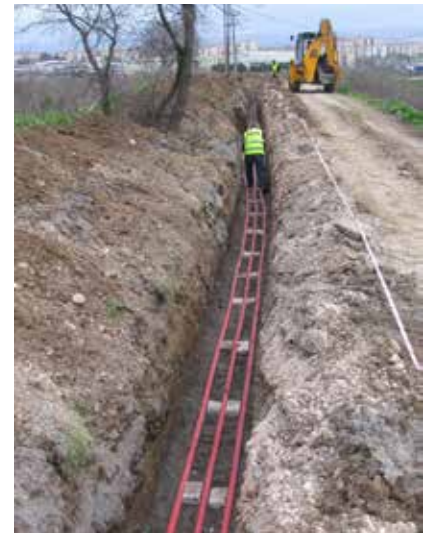
Bursa-İzmir Karayolu, yönlendirilebilir delgi sistemi ile geçilmiştir.
