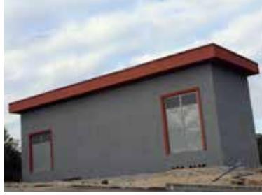
HOSAB Trafo Merkezi
