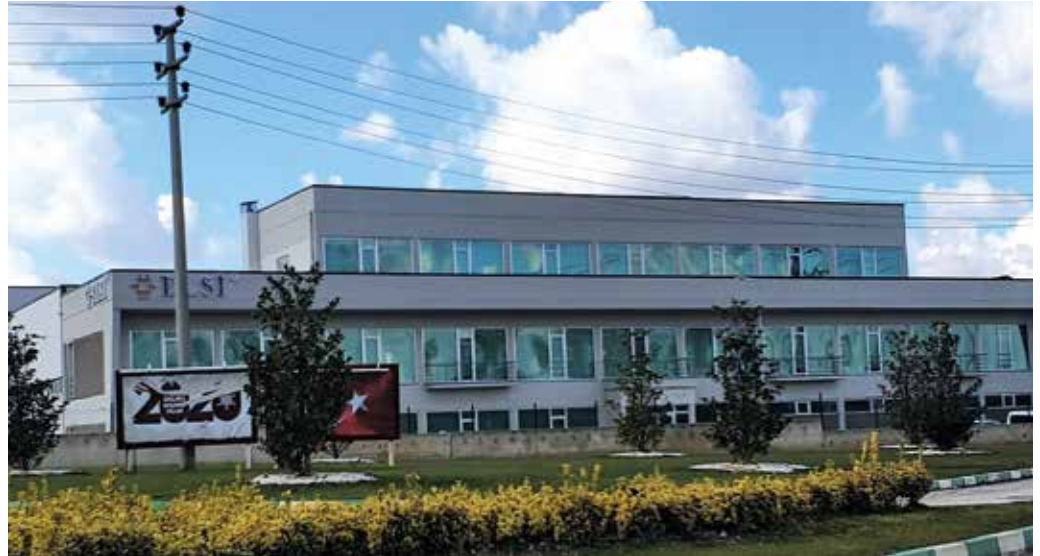
Elsi Elektrik HOSAB Fabrikası
