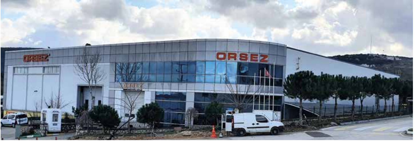
Orsez Sınat ve Tıbbi Gazlar HOSAB Fabrikası
