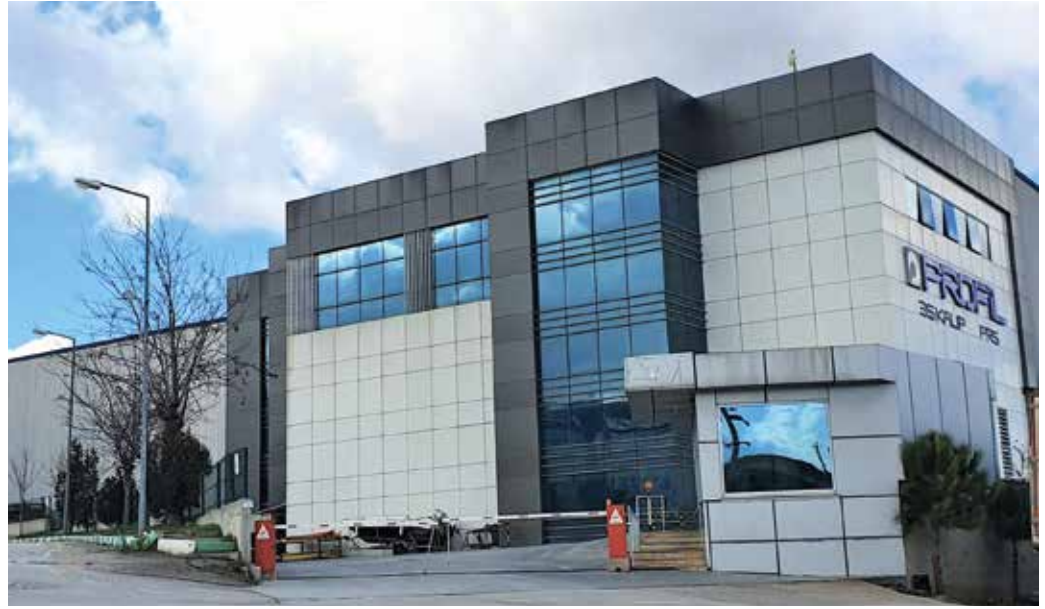
Profil Sanayi HOSAB Fabrikası
