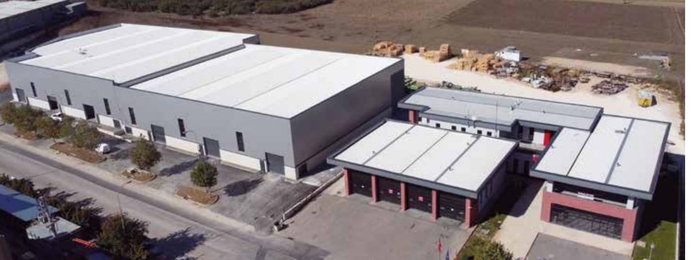
HOSAB Hizmet Destek Alanında İftaiye Binası ve Atölyeler.
