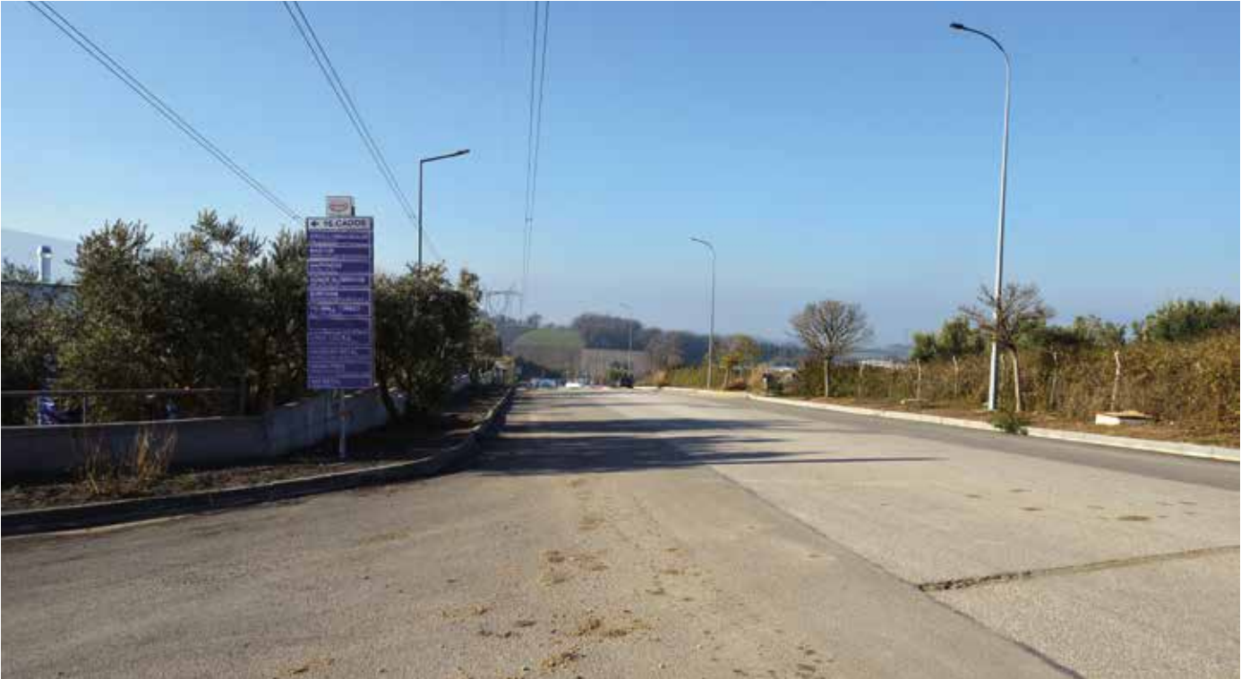
Hasanağa Organize Sanayi Bölgesi'nde cadde aydınlatma çalışmaları, 2019 yılında bölge bünyesine dahil olan eski Akçalar Organize Sanayi Bölgesi yeni adıyla HOSAB 2.Bölge'de de bitirildi. Böylece bölgenin tümünde bu üst yapı tamamlanmış oldu.
